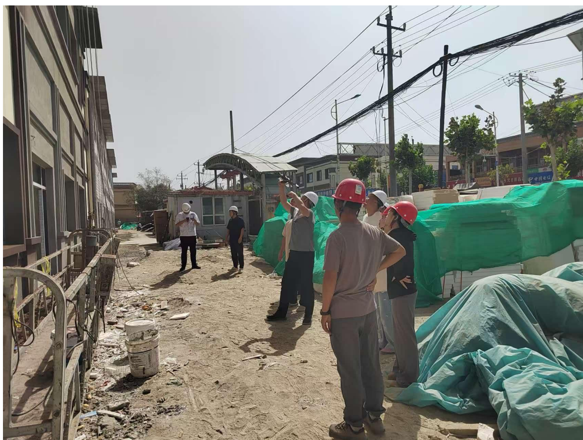
明察暗访组联合现场检查建筑工地（任赛群 摄）
